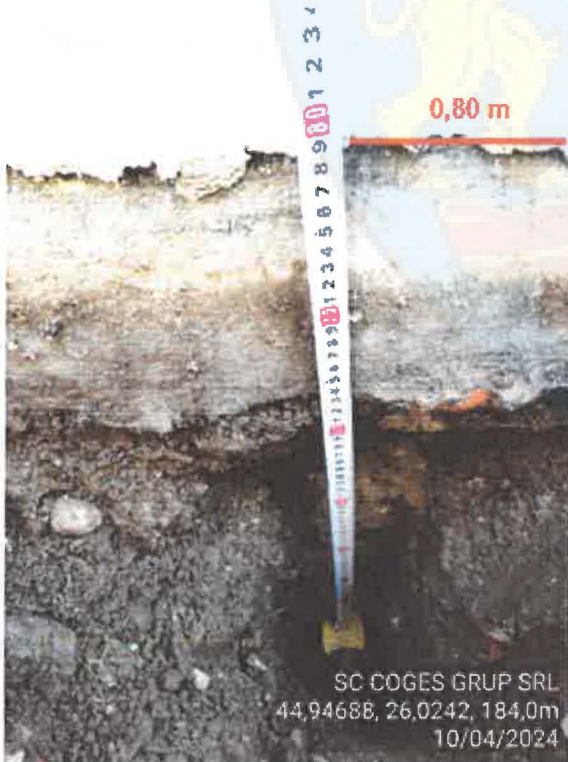
DETALIU FUNDATIE – CLADIRE ANEXA – CORP C2
