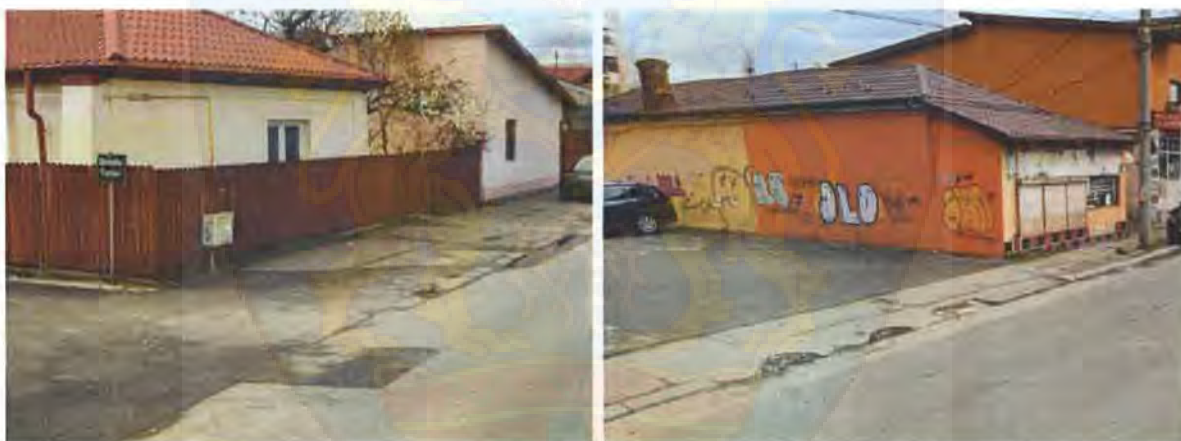
Figura 2.109. Trotuare în stare necorespunzătoare (exemplificare).
