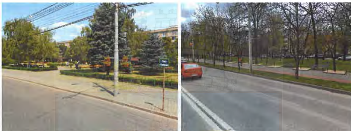
Figura 2.108. Trotuare în stare bună (exemplificare).
