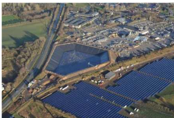
Figura 8.13 - Sistemul de încălzire centralizată cuplat cu energie solară și stocare sezonieră de căldură din Vojens (Danemarca) (cf. cu http://solarheateurope.eu )
