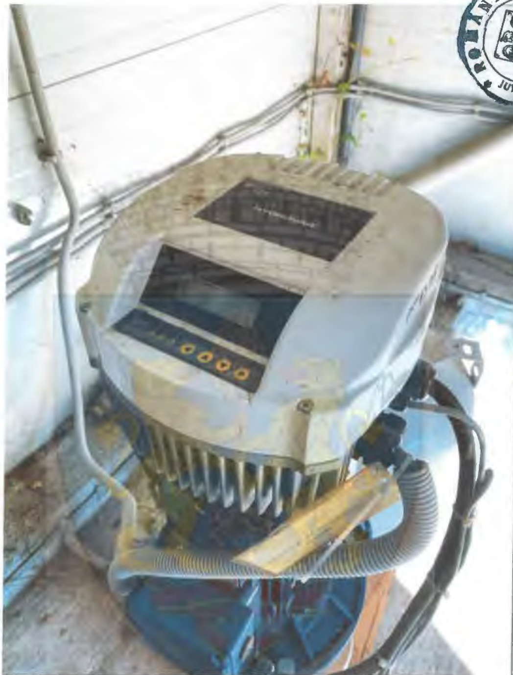
Foto 2 Tabloul de comandă și control al pompei LOWARA, cu display pentru principalii parametri de funcționare ai pompei.
