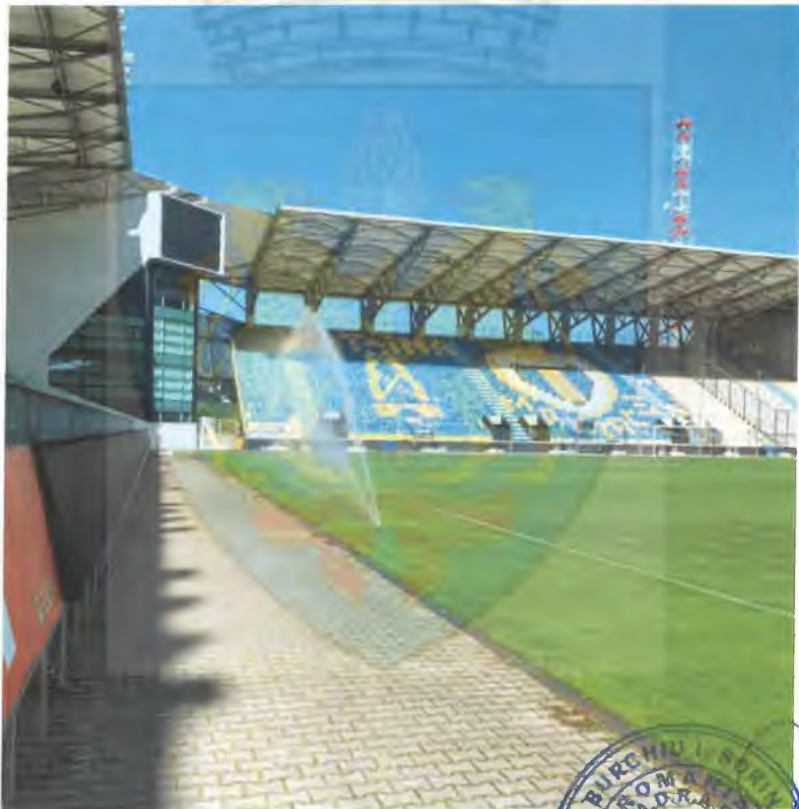
Foto 6 Jetul aspersorului de tip 1 (în funcționare solitară) de pe latura Sud
