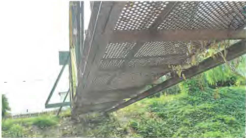
Foto 6, 7, 8, 9, 10: Vedere suprastructura degradata
