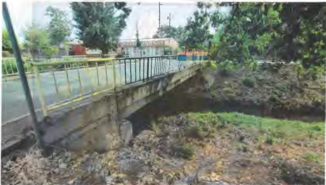
Foto 2: Vedere generala pod din amonte, racordari cu terasamentele amonte
