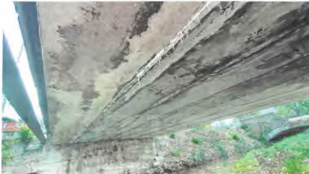
Foto 10: Vedere intrados suprastructura - Stalactite
