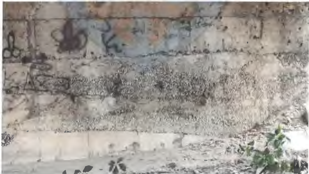
Foto 7,8,9: Degradari culee
