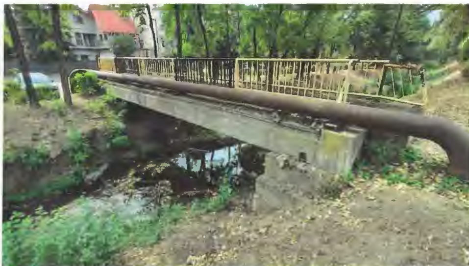
Foto 1: Vedere generala pasarela din aval, racordari cu terasamentele aval
