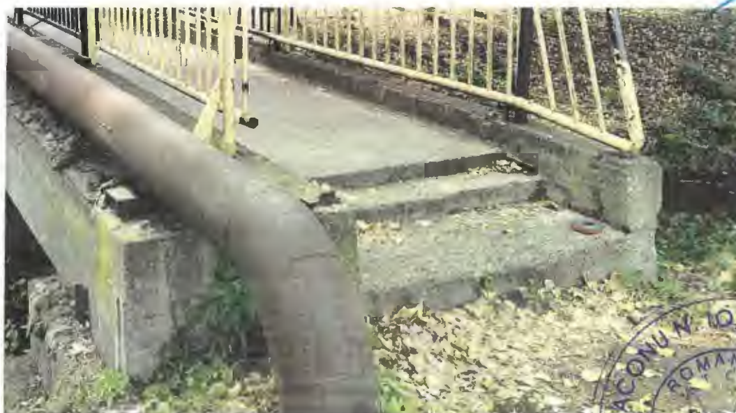
La scările de pe malul drept, parapetul pietonal din partea stanga lipsește.
