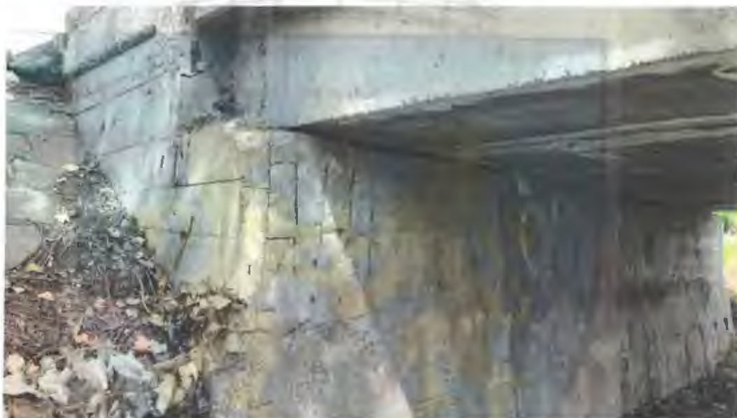
Foto 4,5: Vedere din amonte a culeei dinspre str. Apelor
