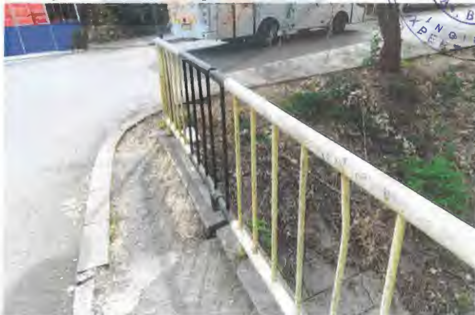
Pe malul drept, in amonte, troaruul pietonal nu are continuitate.
