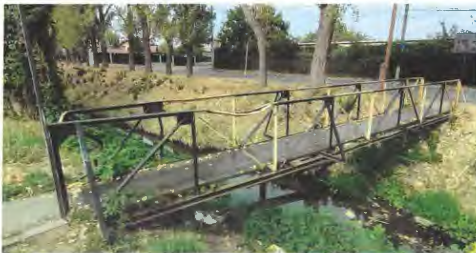
Foto 1: Vedere generala pasarela din aval, racordari cu terasamentele aval
