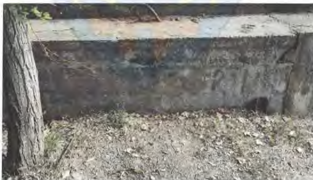
Foto 9, 10, 11, 12: Vedere suprastructura – Fasii cu goluri utilizate la sustinerea conductelor
