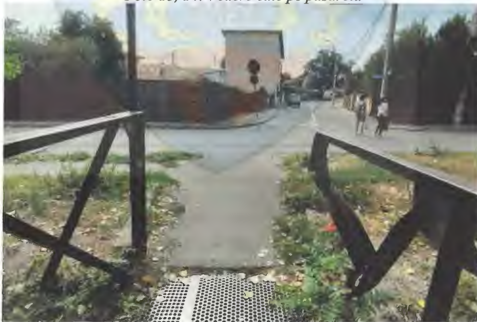
Foto 15: Vedere Rampa dinspre strada Cornatel
