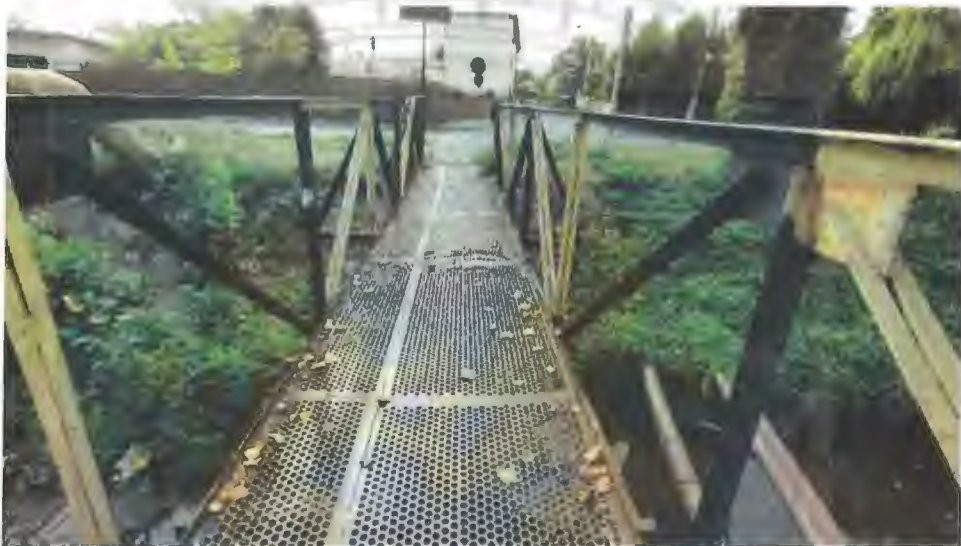
Foto 13, 14: Vedere cale pe pasarela
