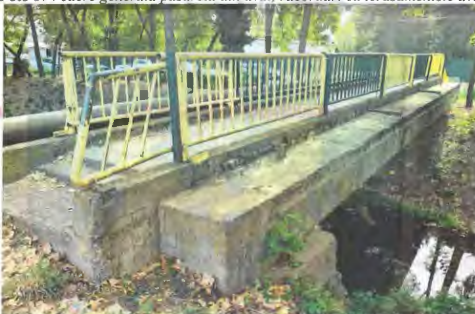
Foto 2: Vedere generala pasarela din amonte, racordari cu terasamentele amonte
