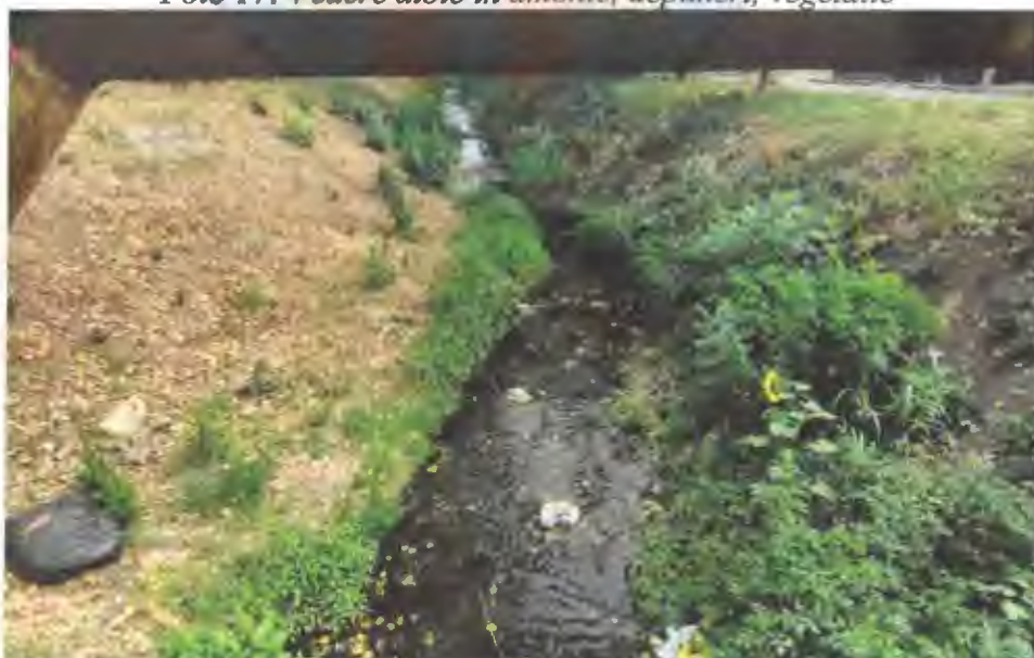
Foto 18: Vedere albie in aval, depuneri, vegetatie
