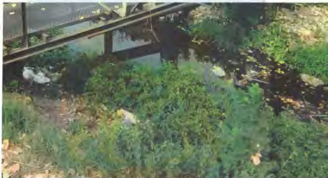
Vedere albie sub pasarela
