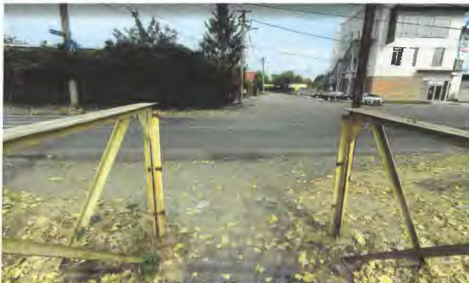
Foto 16: Vedere rampa dinspre Strada Apelor
