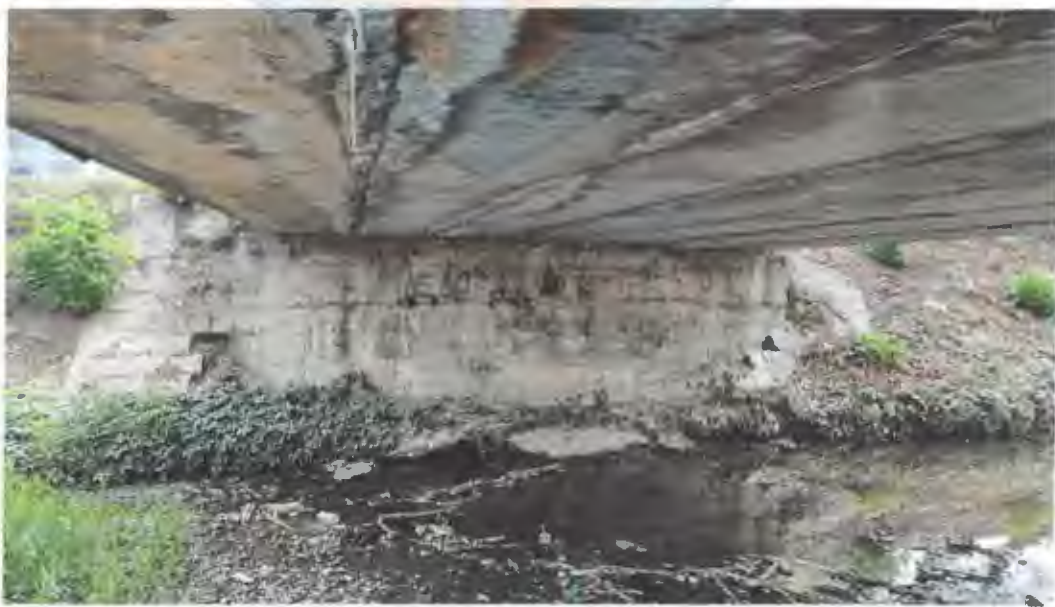
Foto 3: Vedere culeea dinspre str. Cornatel, racordare cu terasamentele mal drept
