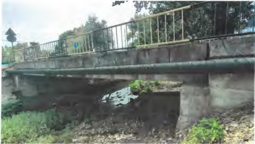
Foto 1: Vedere generala pod din aval, racordari cu terasamentele aval
