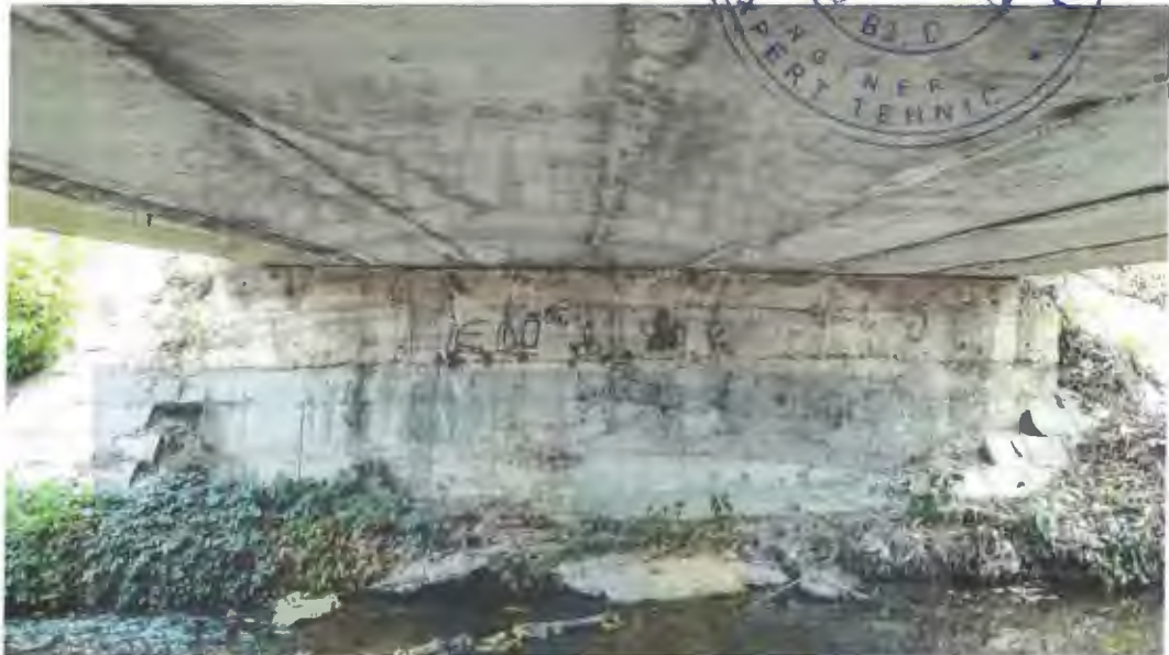
Vedere culee mal drept – Spre strada Cornatel
