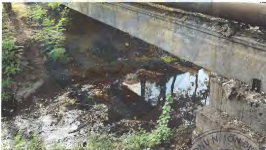
Vedere albie sub pasarela
