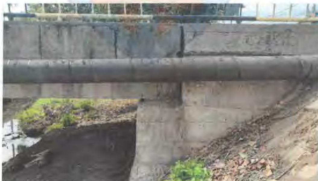
Foto 6: Vedere din aval a culeei dinspre str. Apelor
