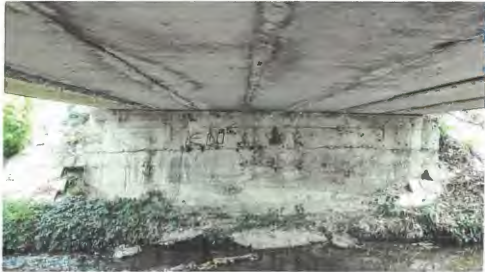
Vedere culee mal drept – Spre strada Cornatel
