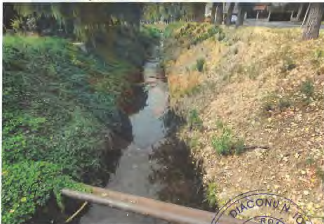
Vedere albie in amonte
