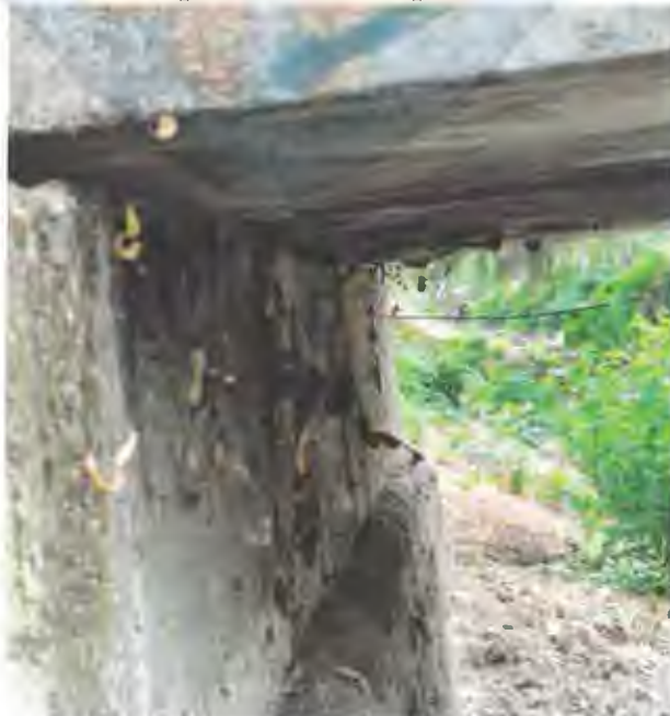
Suprastructura reazama direct pe infrastructuri prin intermediul unui strat de mortar
