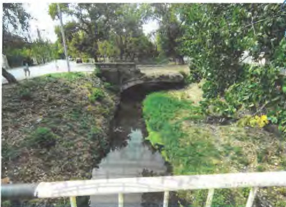
Vedere albie in amonte
