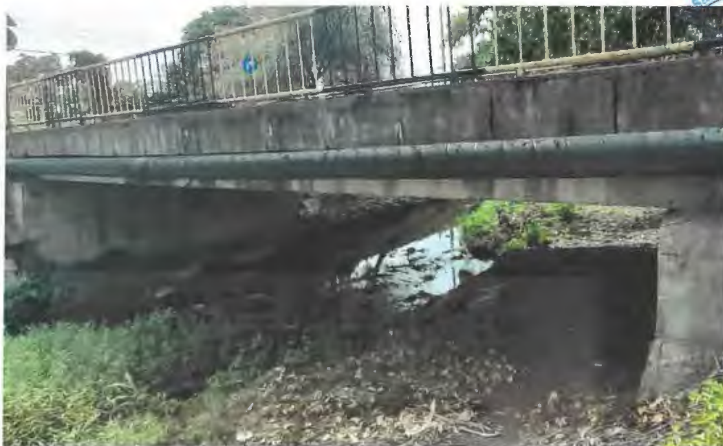
Vedere albie sub pod
