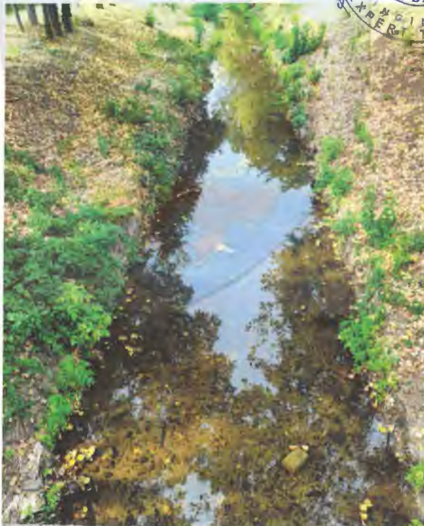
Vedere albie in amonte
