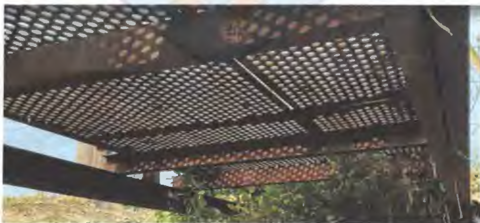
Foto 11, 12: Vedere elemente de rezistenta ce sustin calea – elemente metalice, antretoaze
