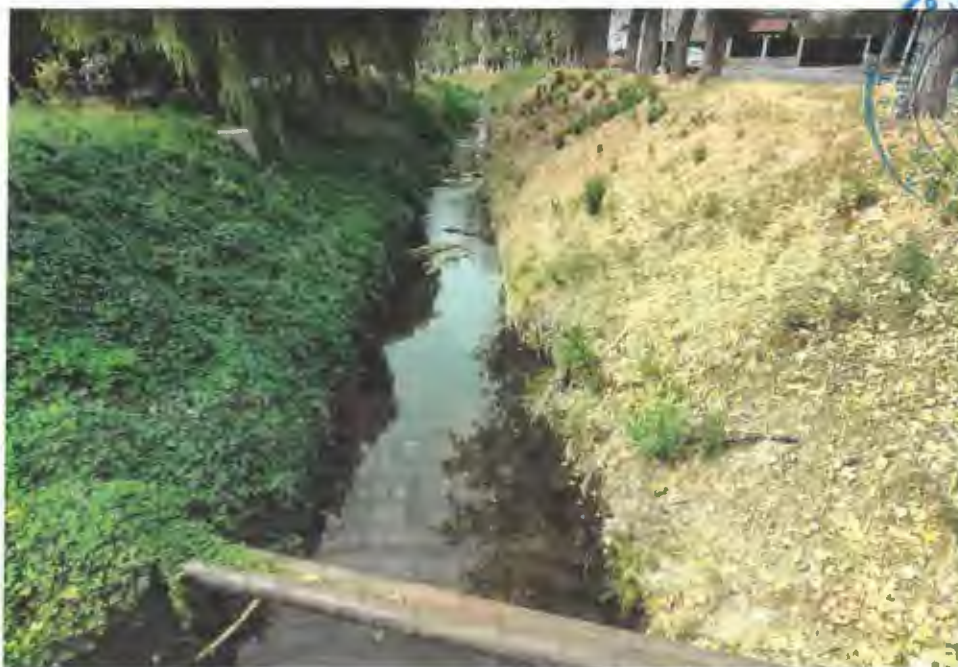
Vedere albie in amonte
