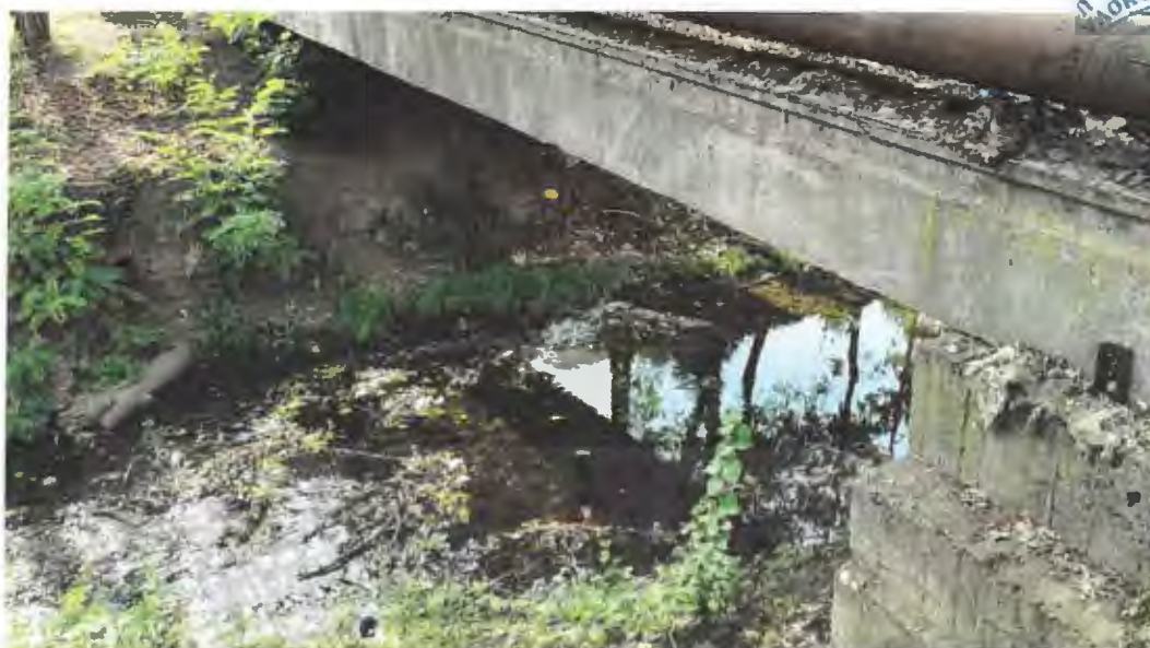
Vedere albie sub pasarela
