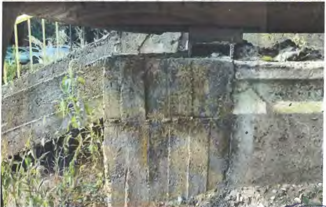
Suprastructura reazama direct pe infrastructuri prin intermediul unui strat de mortar
