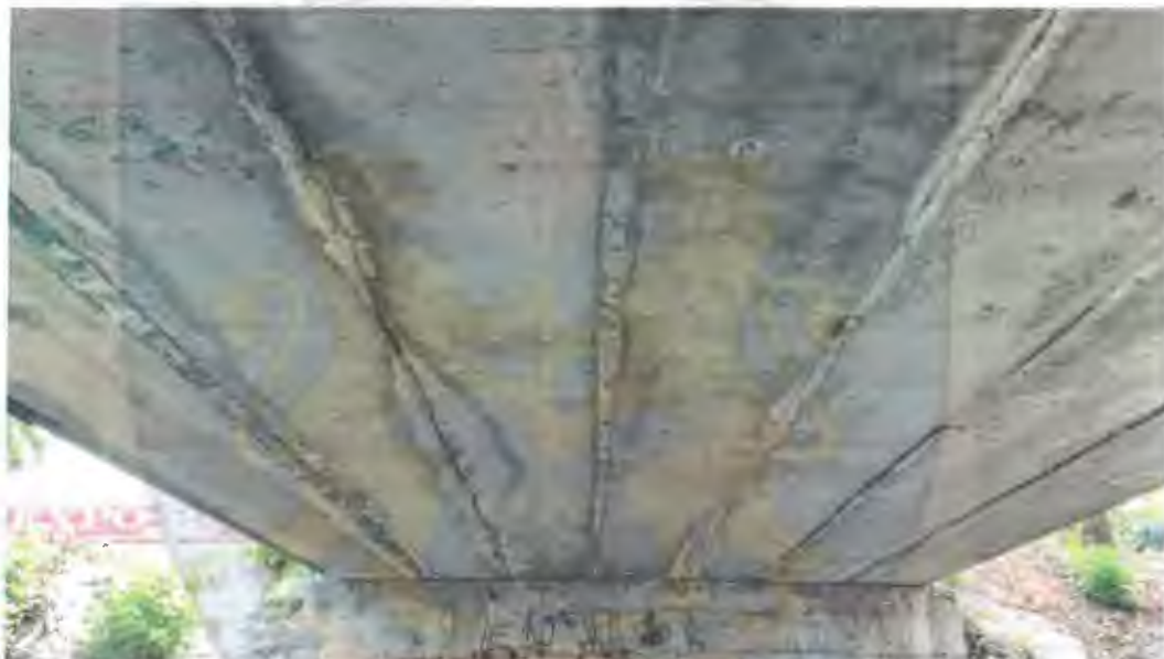
Foto 11: Vedere intrados suprastructura
