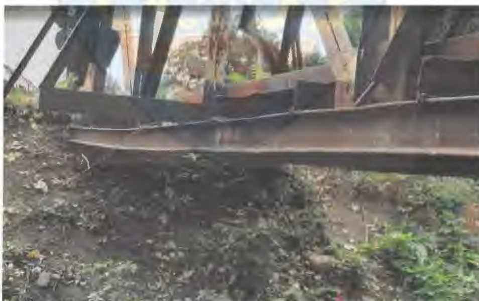
Foto 3: Vedere culee dinspre str. Cornatel, racordare cu terasamentele mal drept
