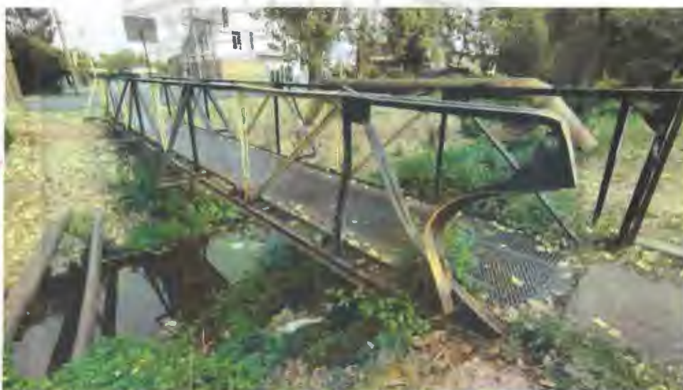
Foto 2: Vedere generala pasarela din amonte, racordari cu terasamentele amonte
