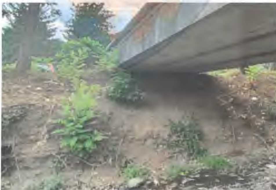
Foto 3: Vedere culee dinspre str. Cornatel, racordare cu terasamentele mal drept
