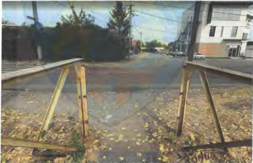
Rampa dinspre strada Apelor
