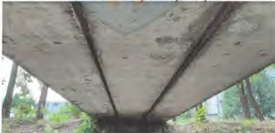
Foto 5: Vedere din aval a culeei dinspre str. Apelor, opritori antiseismici
