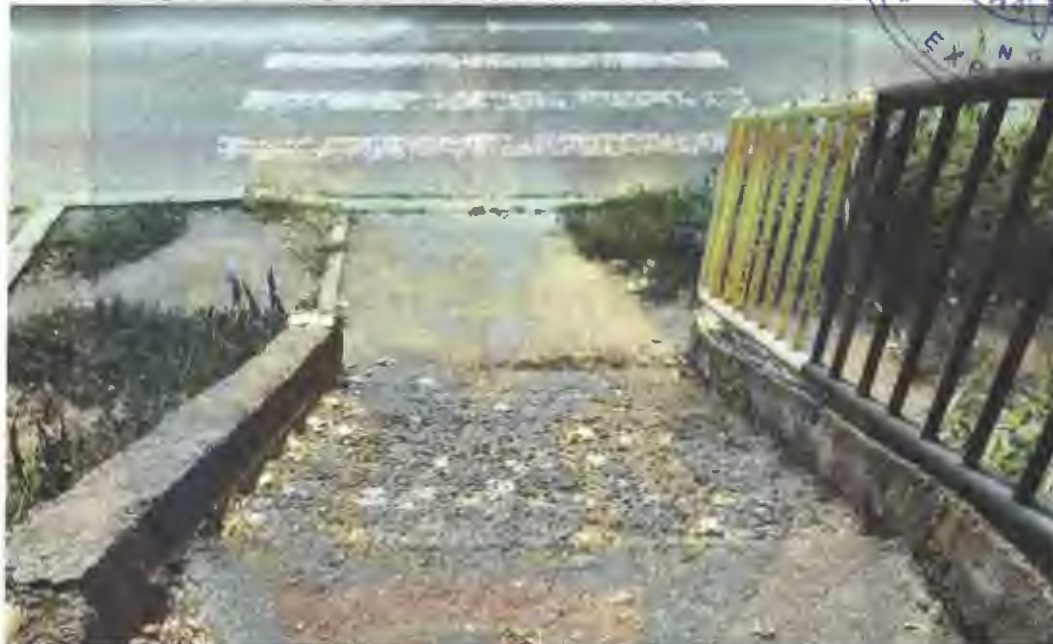
La scările de pe malul drept, parapetul pietonal din partea stanga lipsește.
