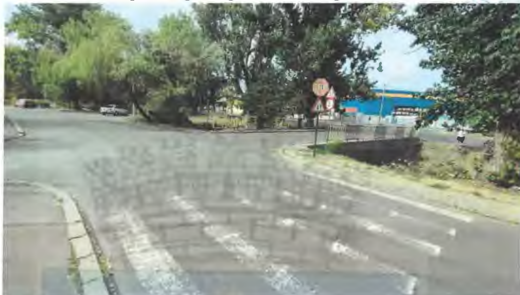
Vedere Rampa Strada Cornatel
