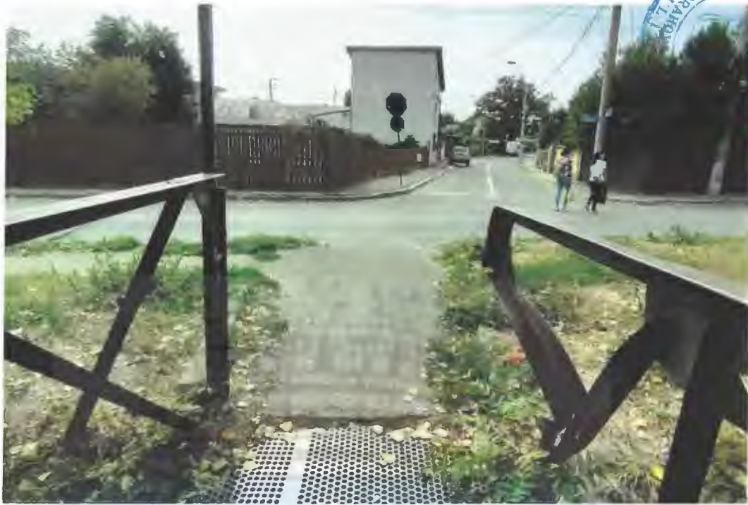
Rampa dinspre strada Cornatel
