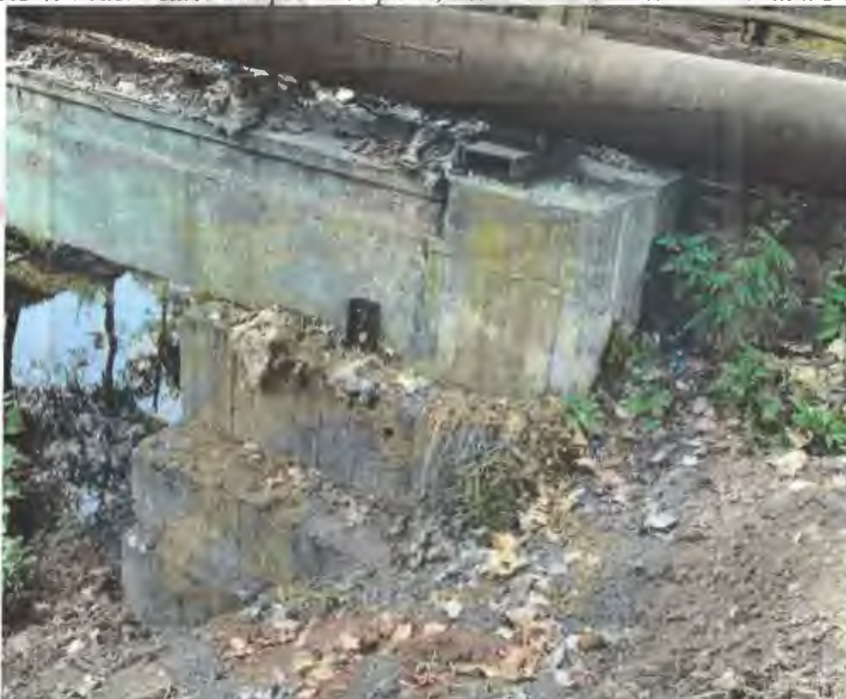
Foto 5: Vedere din aval a culeei dinspre str. Apelor, opritori antiseismici
