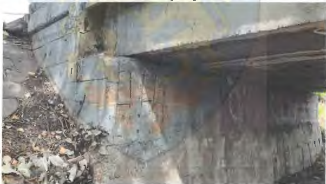
Vedere culee mal stang – Spre strada Apelor
