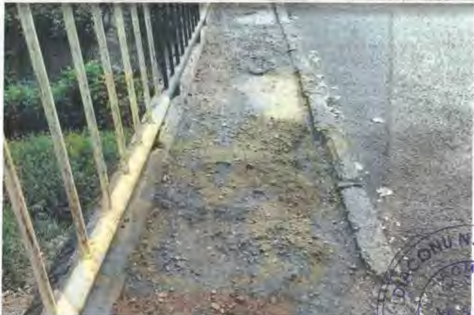
Pe malul drept, in amonte, troaruul pietonal nu are continuitate.
