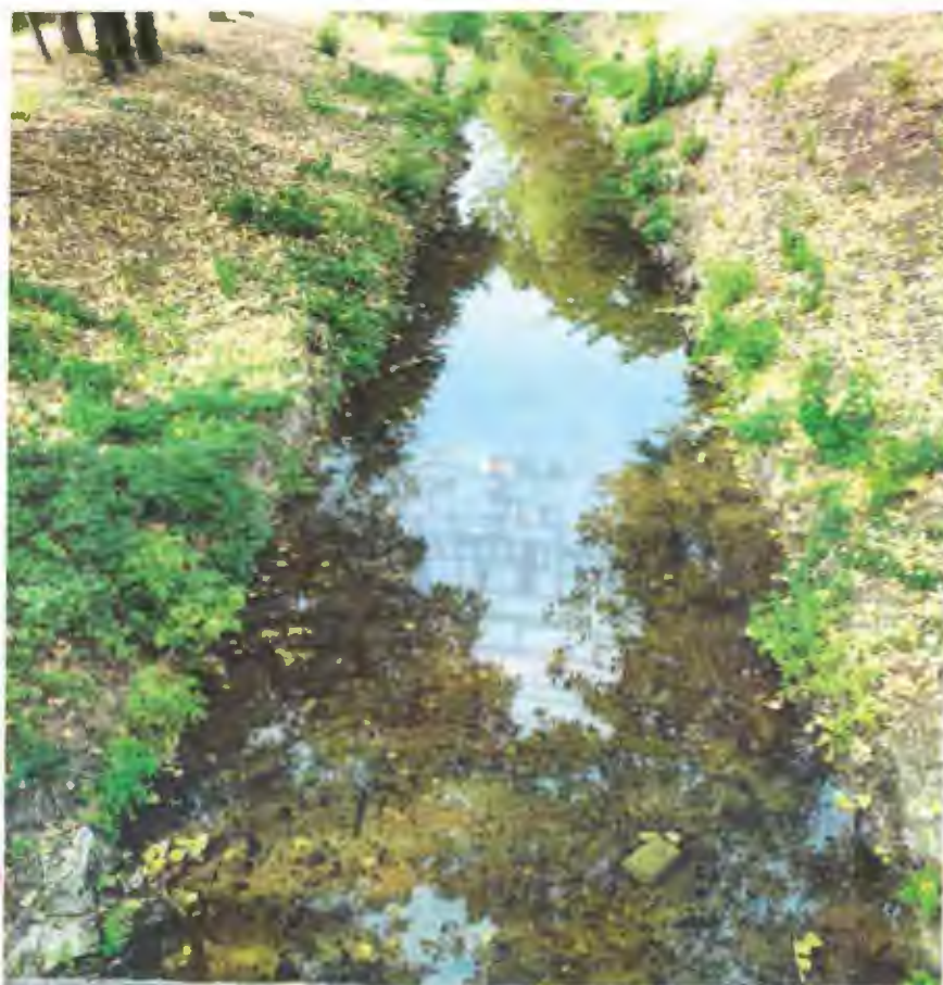
Foto 22: Vedere albie in amonte, depuneri, vegetatie
