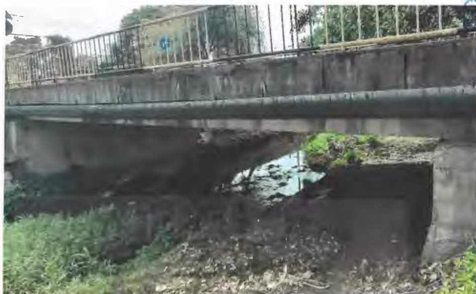
Vedere albie sub pod
