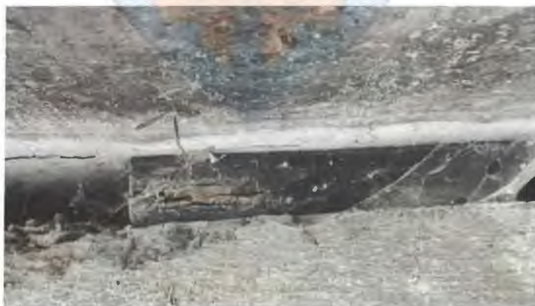
Foto 15: Degradari aparate de reazem
