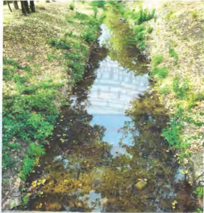
Vedere albie in amonte
