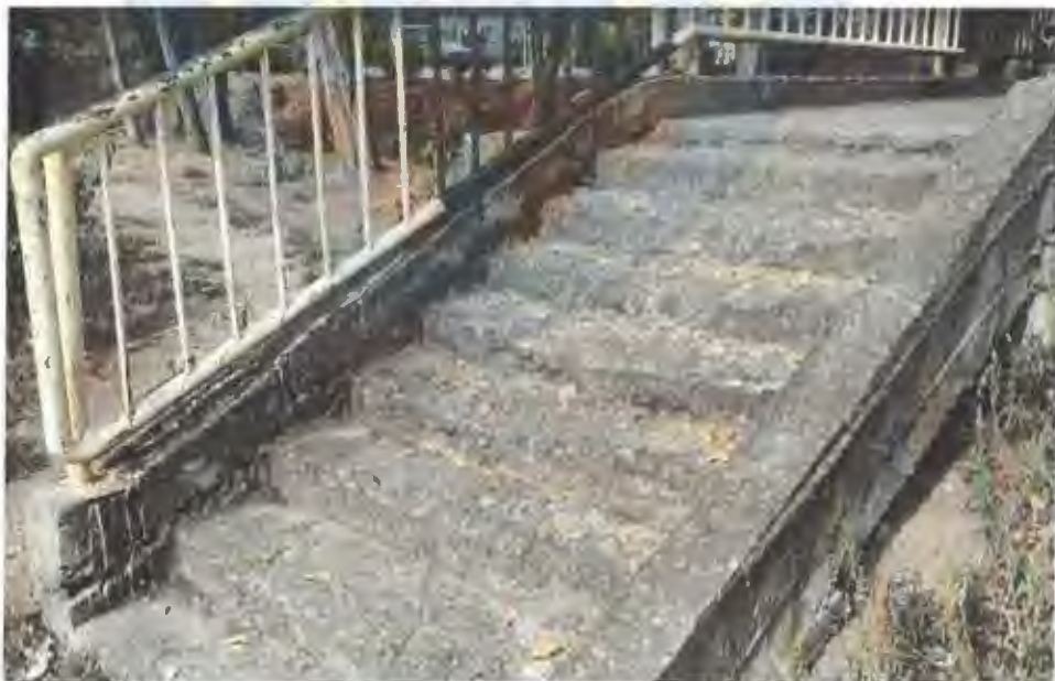
Foto 20, 21: Vedere rampa dinspre Strada Cornatel
