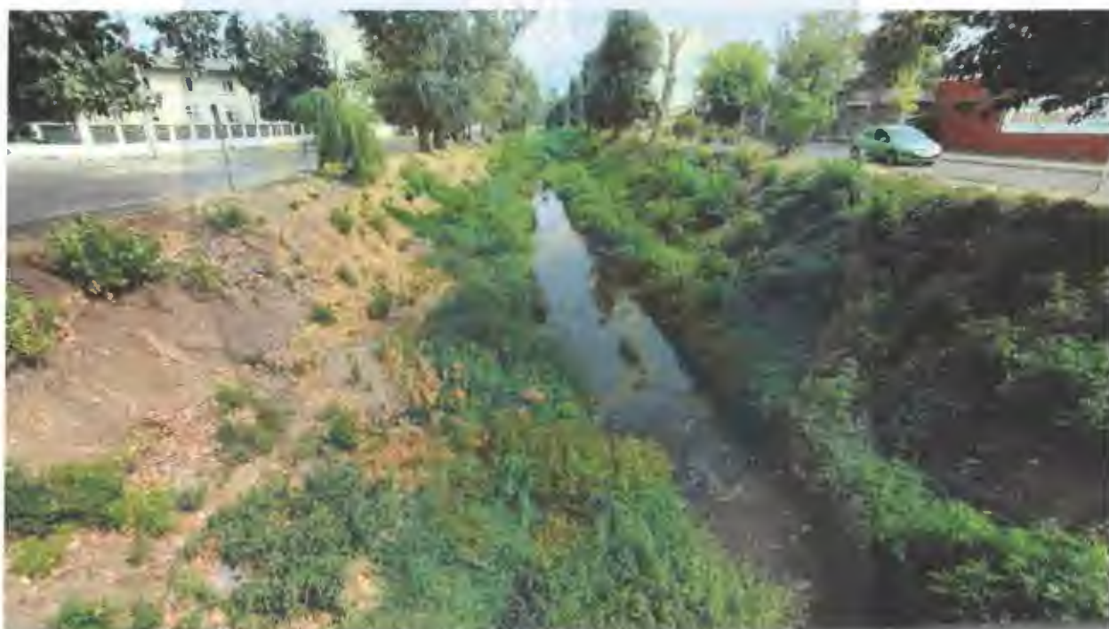
Foto 27: Vedere albie in aval, depuneri, vegetatie
