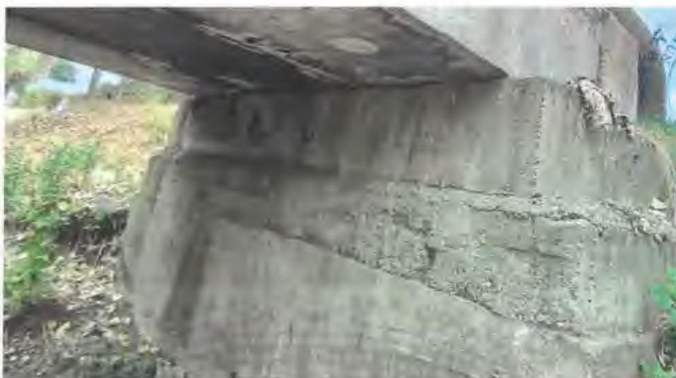
Foto 4: Vedere culee dinspre str. Apelor, racordare cu terasamentele mal stang
