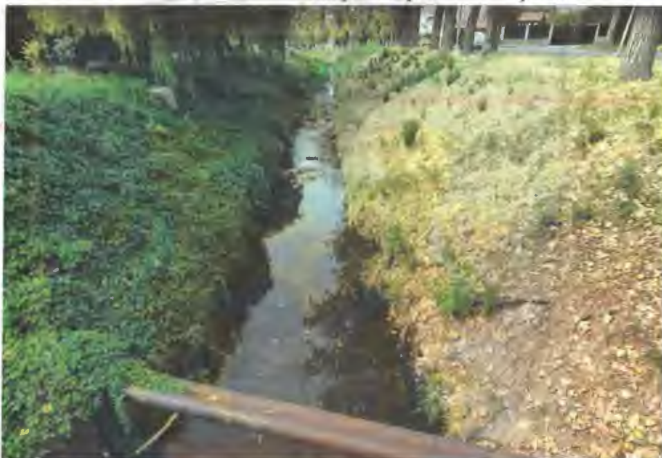
Foto 17: Vedere albie in amonte, depuneri, vegetatie
