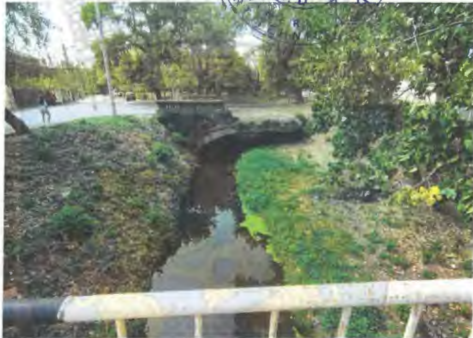
Vedere albie in amonte
